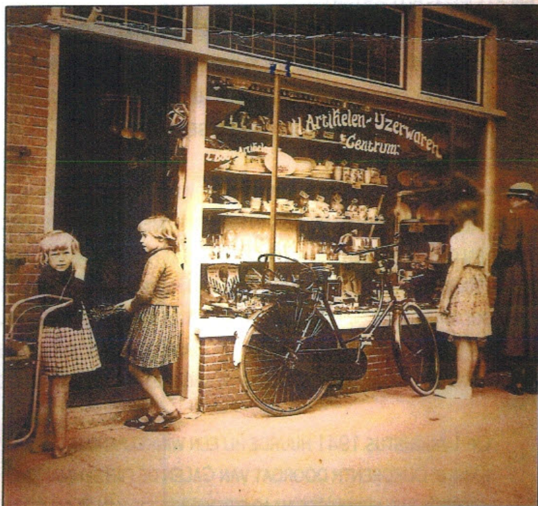
Oudst bekende gevel, Voorstraat
