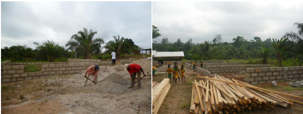
Boven: de materialen, waaronder zand en hout, zijn aangeleverd. Er wordt hard gewerkt aan de muren. Onder: de oudere jongens in het weeshuis helpen een handje mee.
