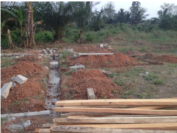
Links: de te bouwen klaslokalen worden afgebakend, men begint met de fundering. Rechts: de eerste stenen zijn gelegd.
