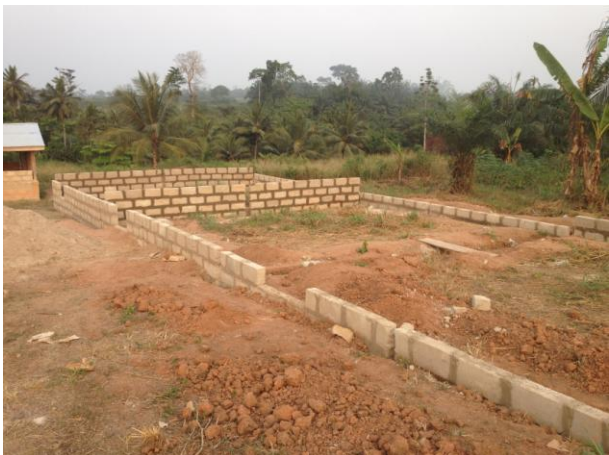
Links: de te bouwen klaslokalen worden afgebakend, men begint met de fundering. Rechts: de eerste stenen zijn gelegd.
