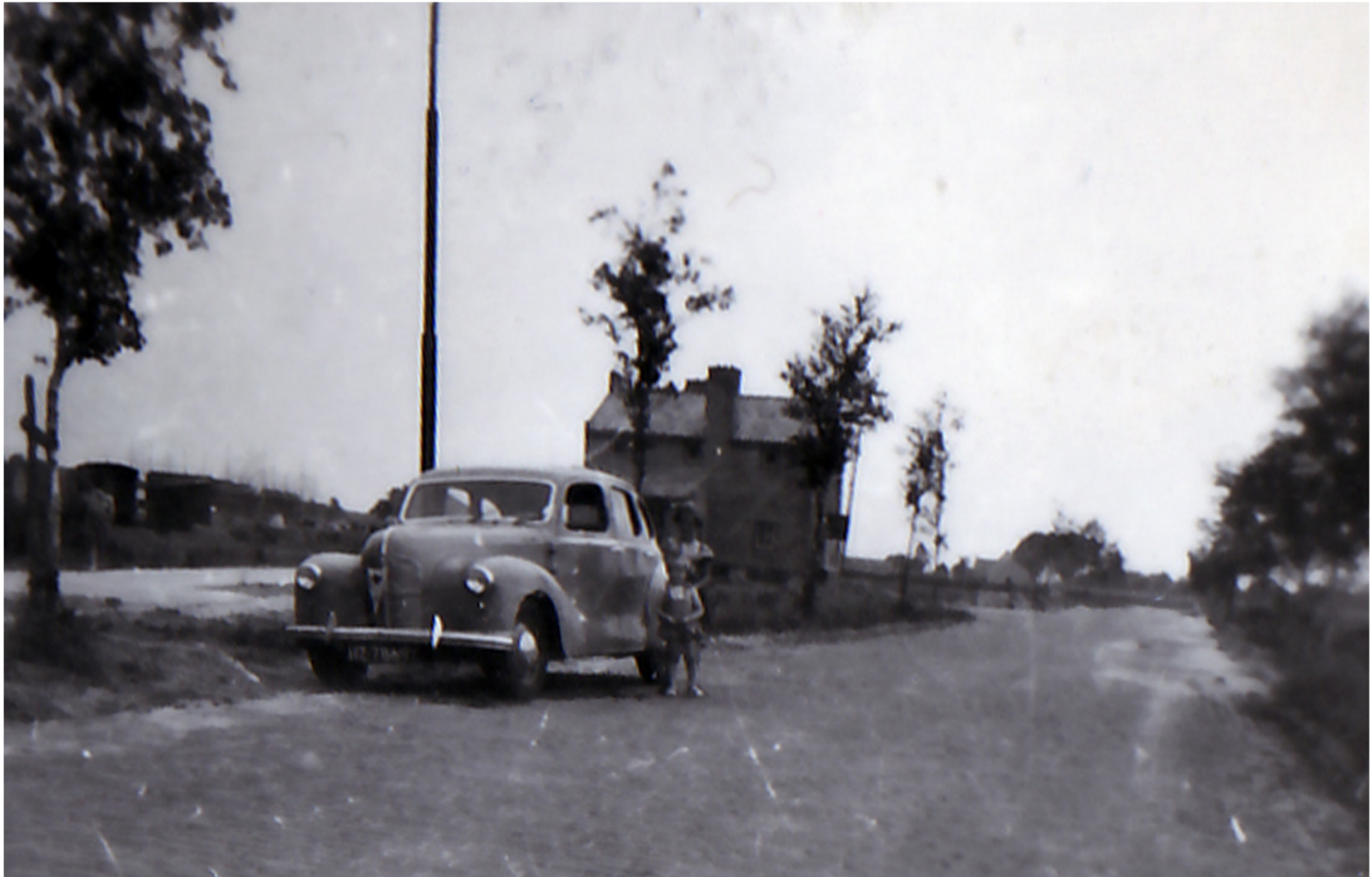
Julianalaan, 1952 Het huis van de fam. van Voorden in aanbouw
