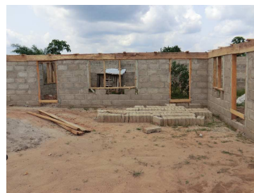
Bouw van het klaslokaal en de schoenmakerij
