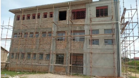
Foto 1: Eindmuur van het slaapgebouw. Let op de grijze leidingen die het regenwater van beide zijden van de het slaapgebouw naar beneden afvoeren. Van daaruit gaat het water via een ondergrondse leiding naar de grote ondergrondse tank (250.000 ltr)
