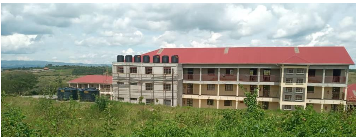
Foto 6: "Rooftop-tanks" bovenop het trappenhuis van het slaapgebouw. Een aantal van deze tanks voeden de douches en toiletten binnenin dit gebouw. En de overige rooftop tanks voeden de grote zwarte tanks (links op de foto) met water en houden dat onder druk.
