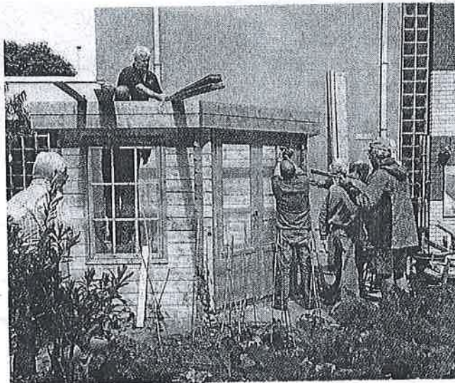
Het tuinhuisje wordt geplaatst.
